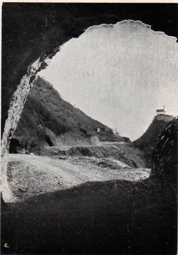
VEDUTA PRESA DALLO SBocco SUD DELLA GALLERIA PRESSO CASE FONTANA. IN FONDO LA CHIESETTA DI SANTA GIULIANA.
