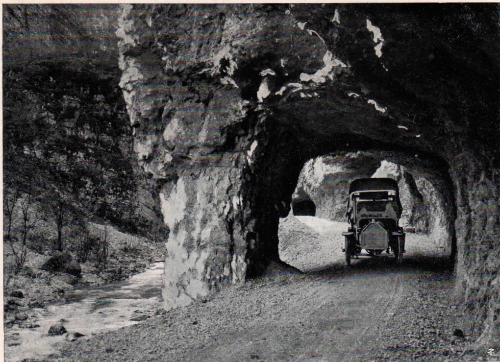
GALLERIE DELLA NUOVA STRADA POCO A MONTE DI STUA. IMBOCCHI SUD.
