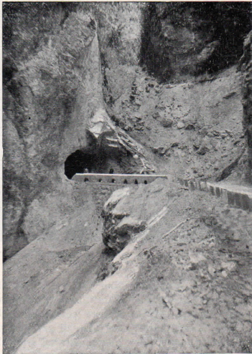
LA VALLE DEI CORVI ED IMBOCCO SUD DELLA GALLERIA DELLA CROCETTA.
