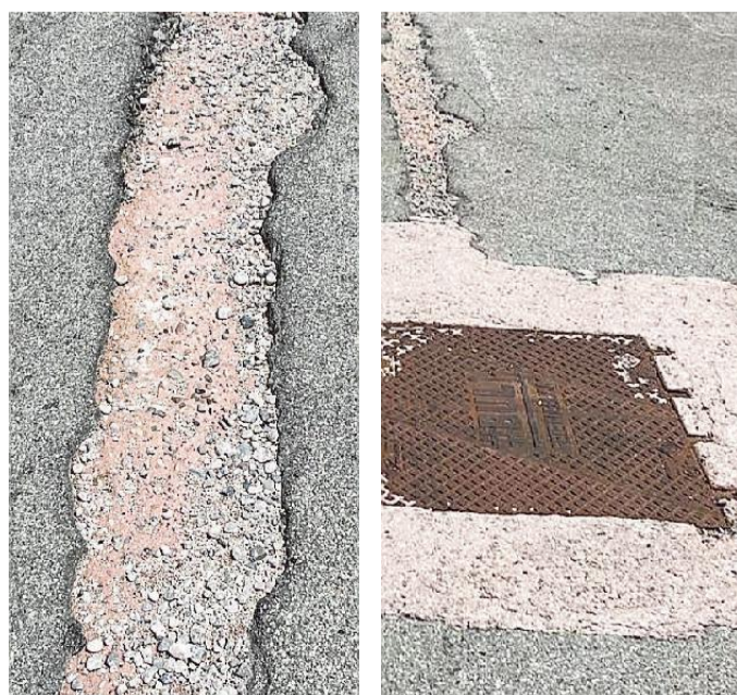
Due immagini dello stato di alcune vie di Alpago post posa della fibra
